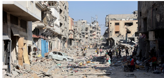
شارع؛ دمار بشكل كبير في إحدى شوارع الخرطوم
