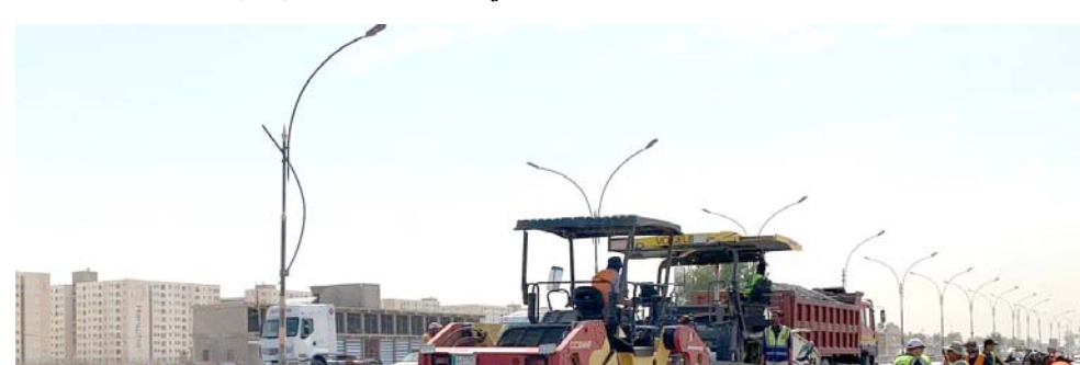
توسعة الطرق والجسور تنفيذ أعمال توسعة طريق بغداد بسماية
