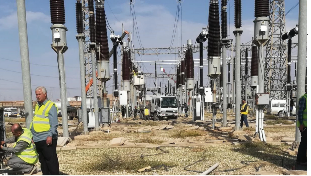
صيانة: فرق الصيانة في إحدى محطات توليد الطاقة الكهربائية
