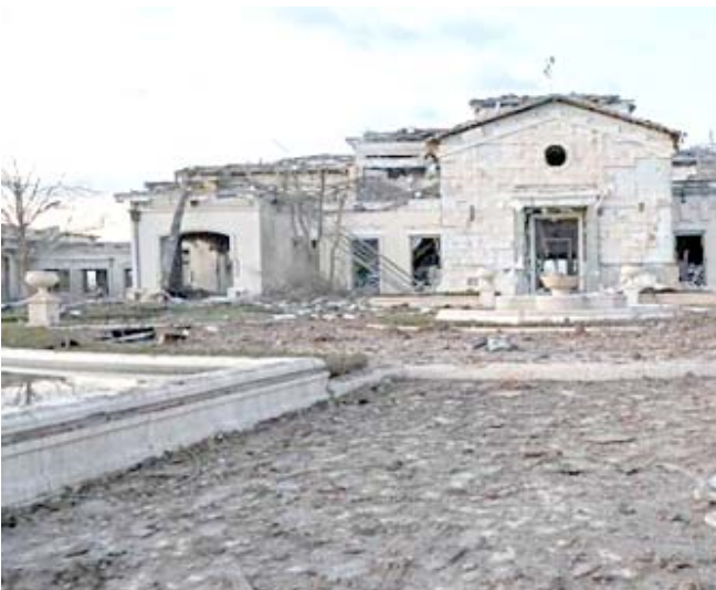
دمار: مبنى مدمر في أربيل نتيجة القصف الصاروخي الإيراني
